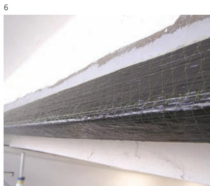
1. Schema Rinforzo Travi Sperimentazione taglio 2003-2004. 2. Trave US90. 3. Trave US45 . 4. Trave USV. 5. Curing dei compositi di rinforzo di un pilastro. 6. Qualità della stratificazione del composito posto in due strati di diversa larghezza).
