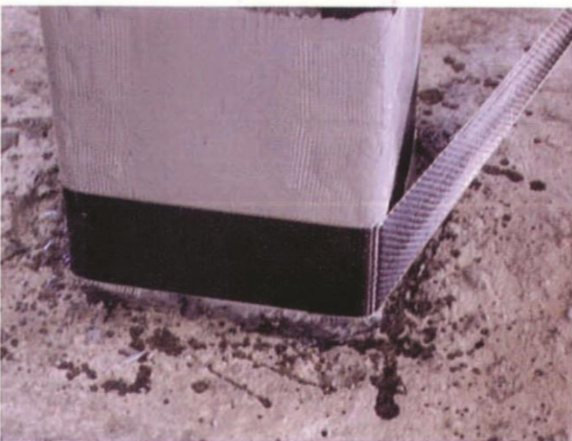
Posa in opera della fasciatura
