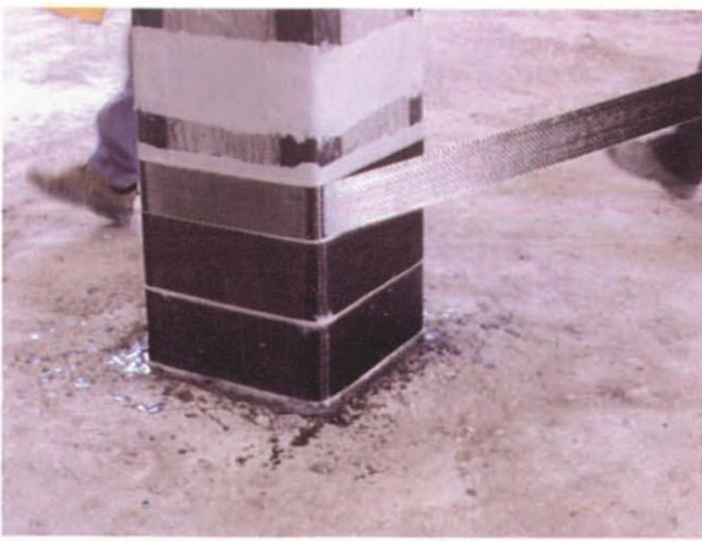
Posa in opera della fasciatura
