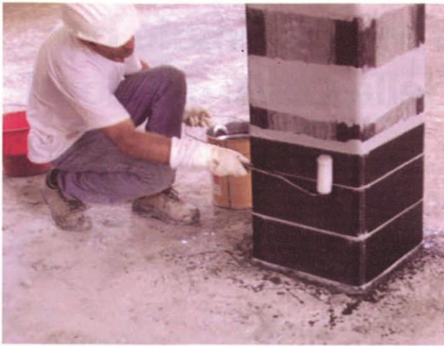
Posa in opera della fasciatura
